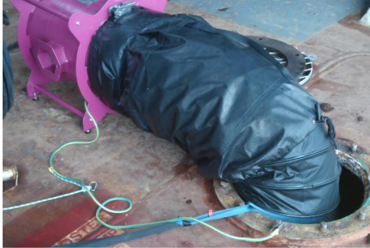
Portatif Fan ile Örnek Tank Havalandırması
